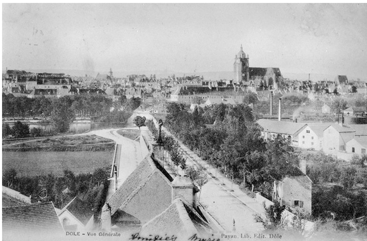
Dole - Vue Générale.
