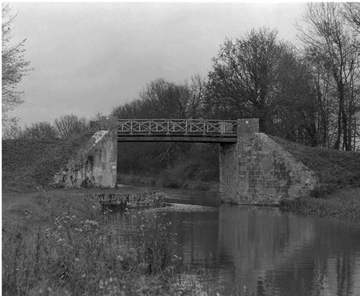
Vue d'ensemble prise de l'amont.
