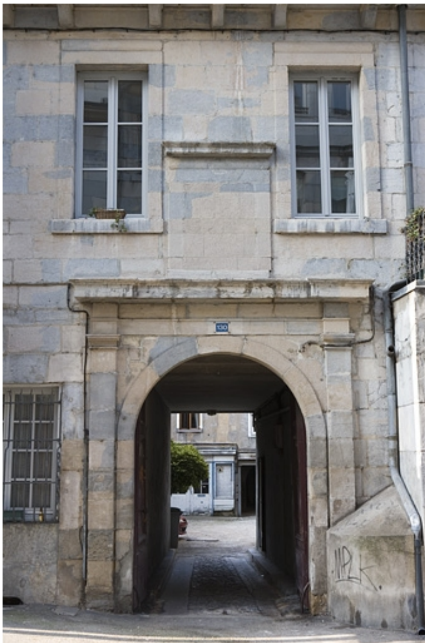
Vue d'ensemble du portail d'entrée.
