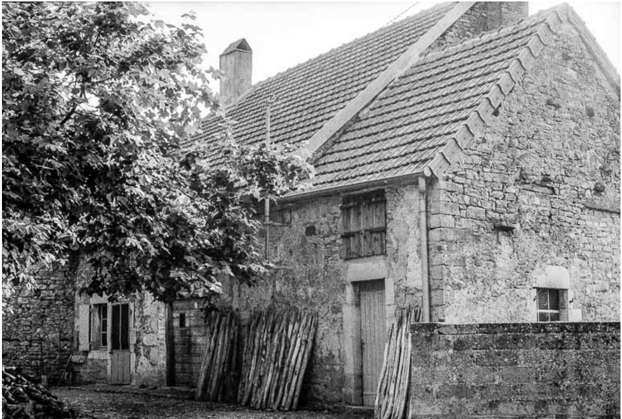
Ferme cadastrée 1960 AE 119, située rue Saint-Aignan : façades antérieure et latérale droite.
