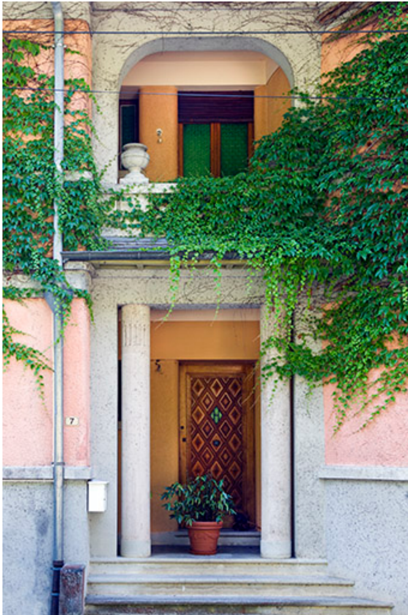
Logement patronal de 1931, façade antérieure : entrée.
