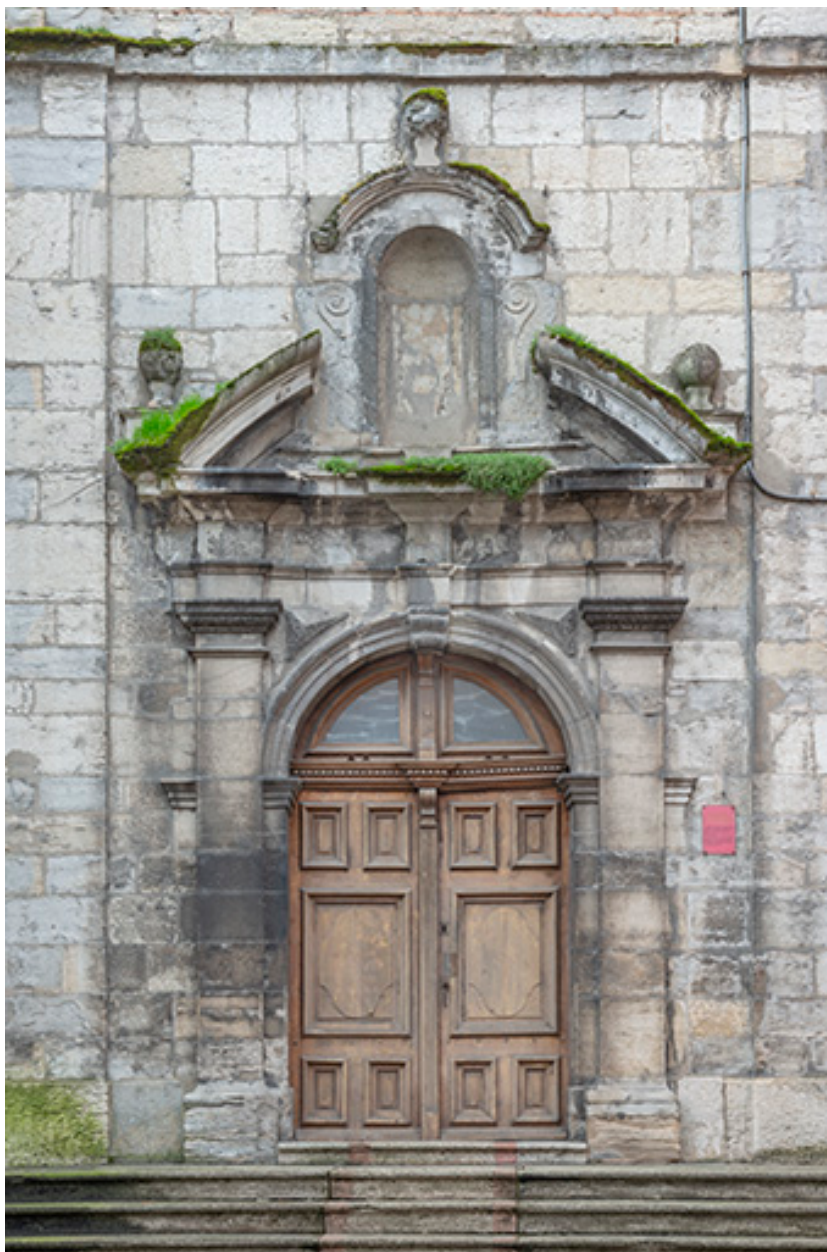
Façade nord. Porte centrale.
