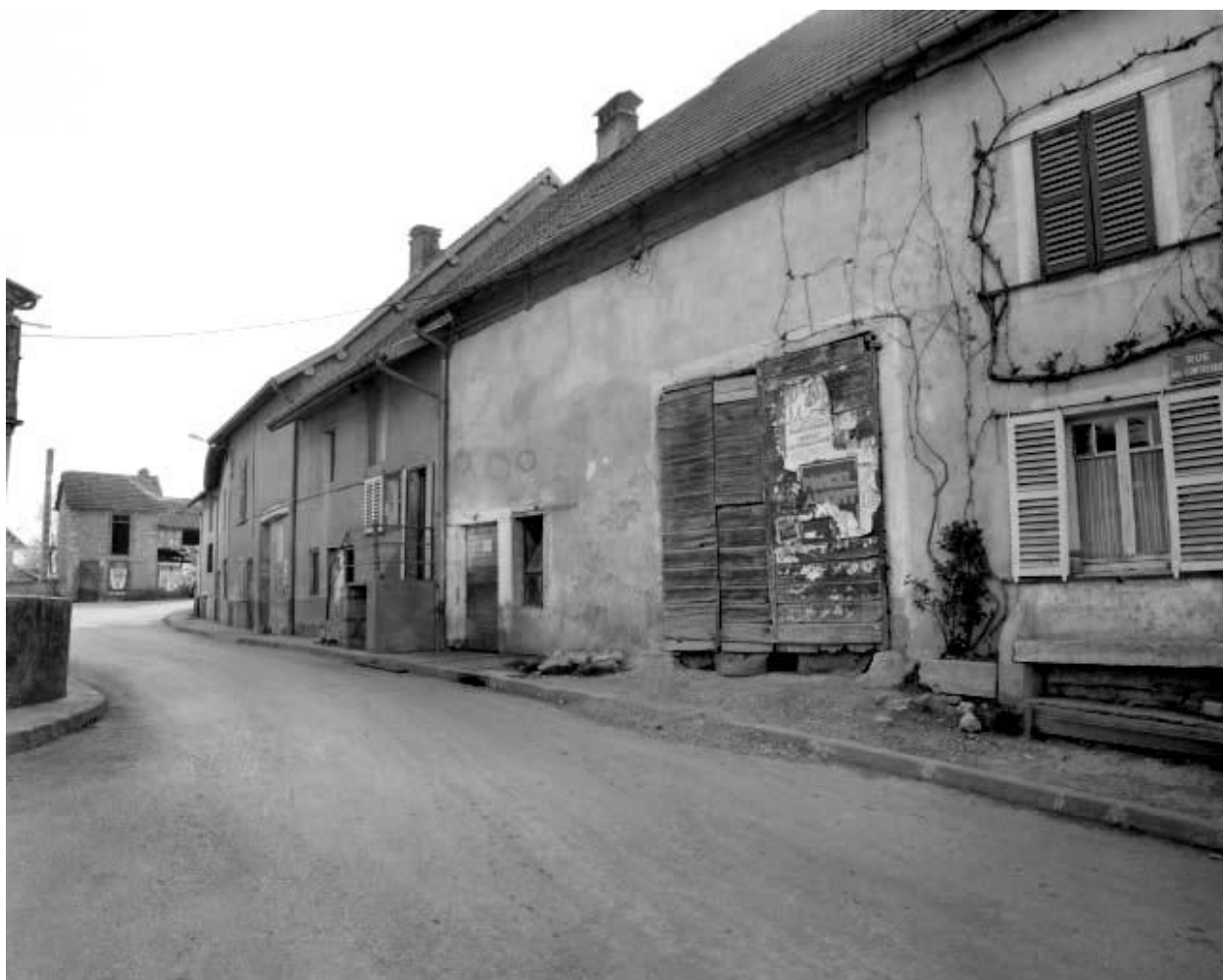
Ferme située 2 rue des Contrevaux.
