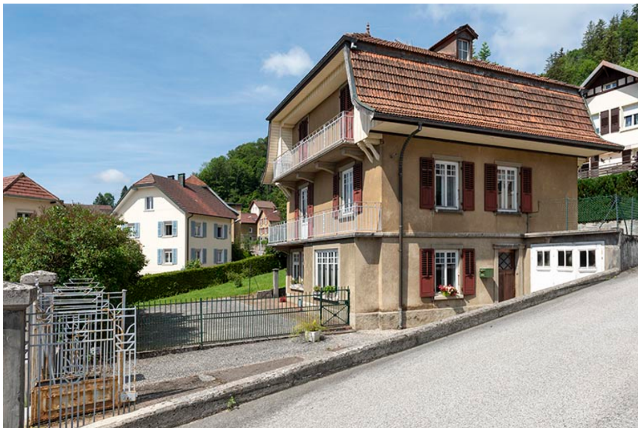
Façade latérale droite, de trois quarts gauche.
