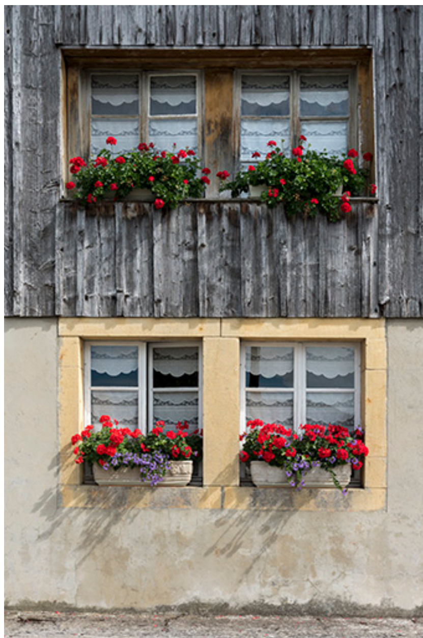
Façade antérieure : fenêtres horlogères.
