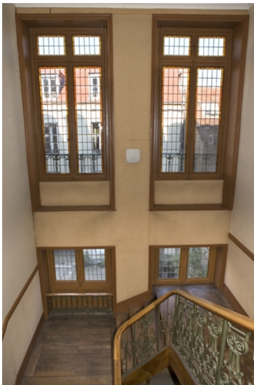
Détail des fenêtres éclairant l'escalier principal.
