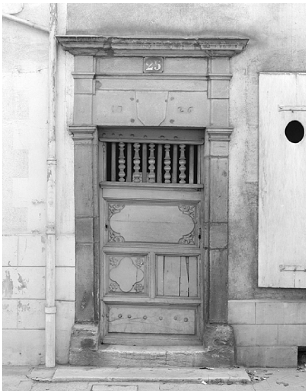
Façade latérale, porte d'entrée avec la date 1726.
