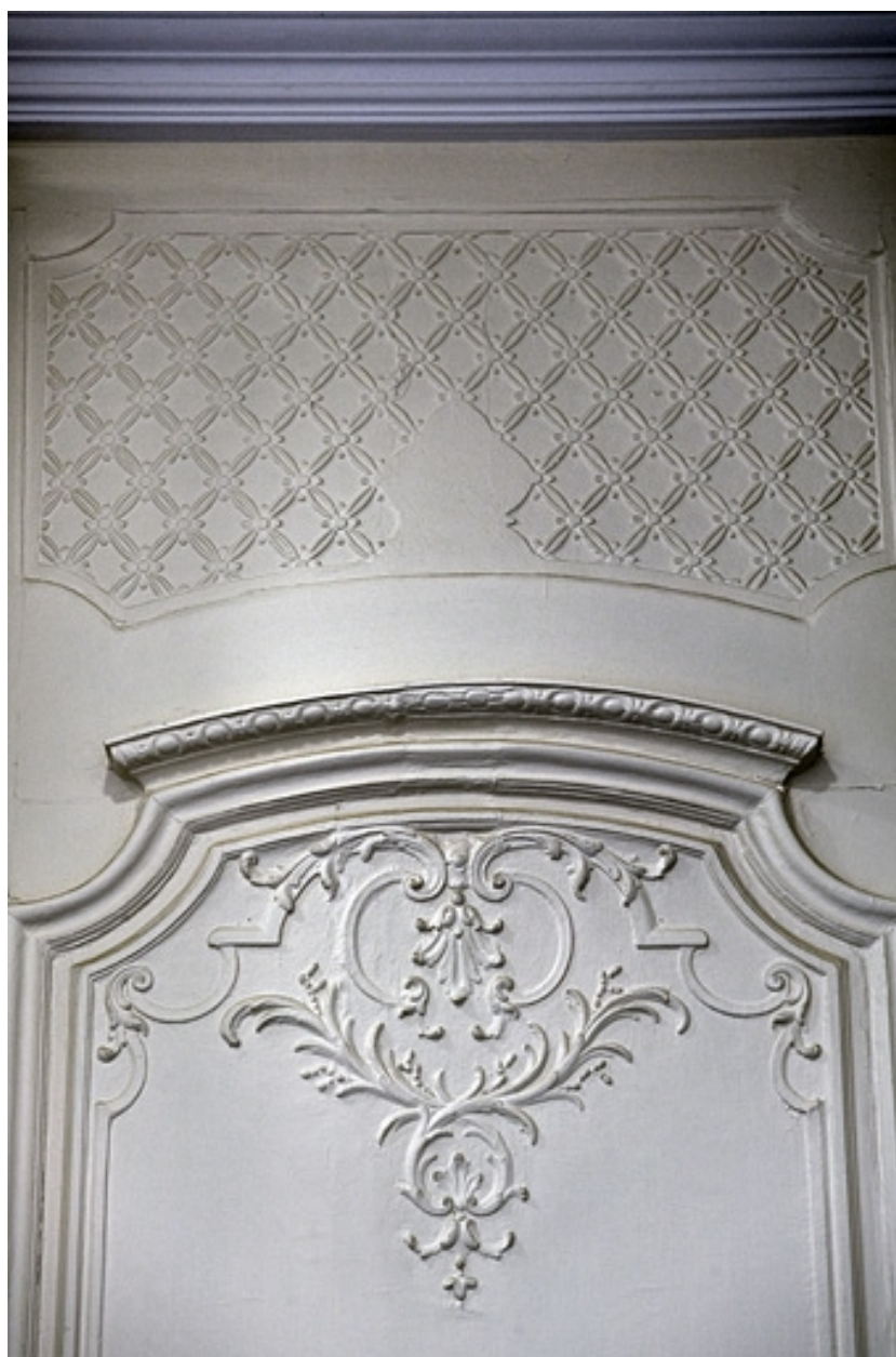
Intérieur : détail d'un lambris d'un ancien cabinet.
