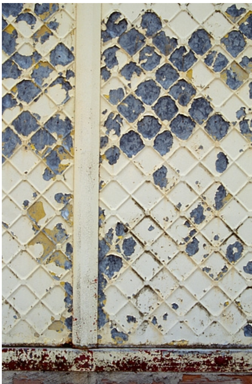
Détail d'un panneau métallique (façade latérale gauche).
