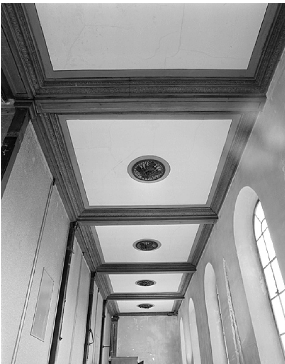
Plafond de la tribune sud.
