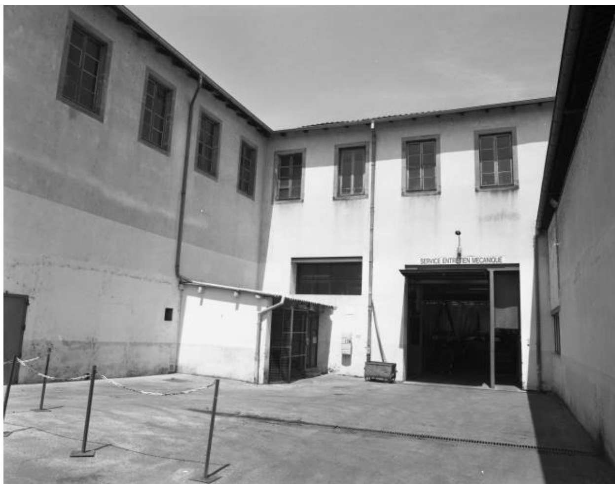
Atelier outillage-entretien mécanique. Façade sud.
