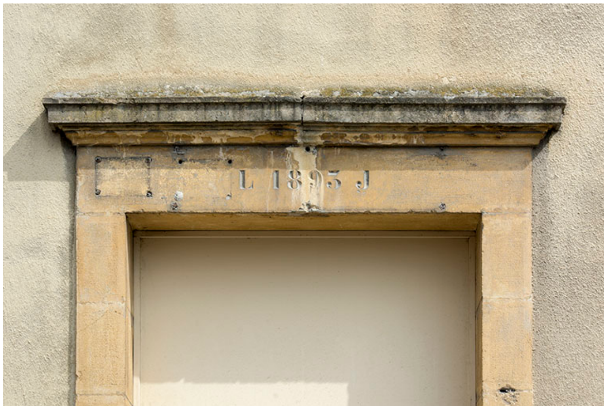
Bâtiment sur rue : linteau daté 1893.
