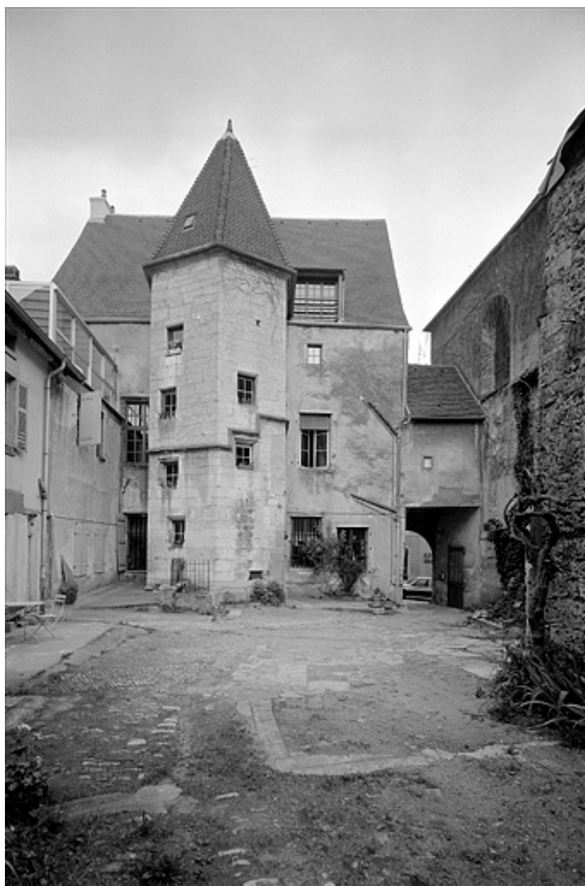
Façade postérieure avec tour d'escalier hors-oeuvre.
