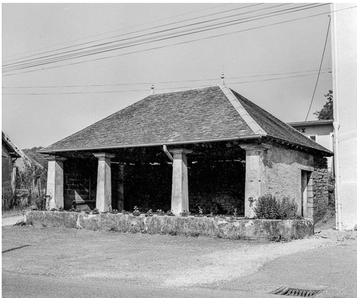
Extérieur, vue d'ensemble.
