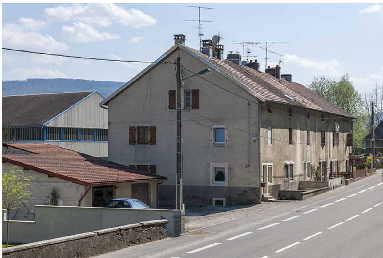
Logement d'ouvriers vu de trois quarts gauche.
