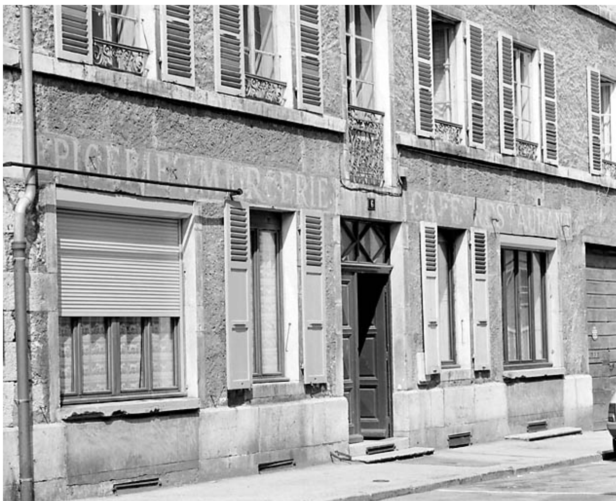
Baies de l'élévation antérieure.
