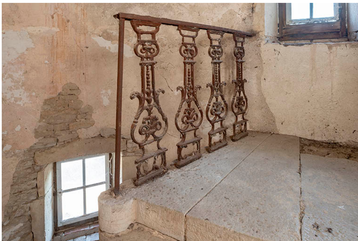
Escalier en vis, comble.
