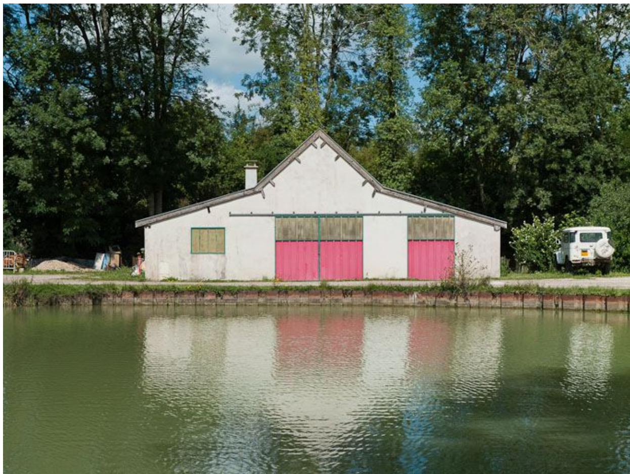
Vue d'un hangar sur le port.
