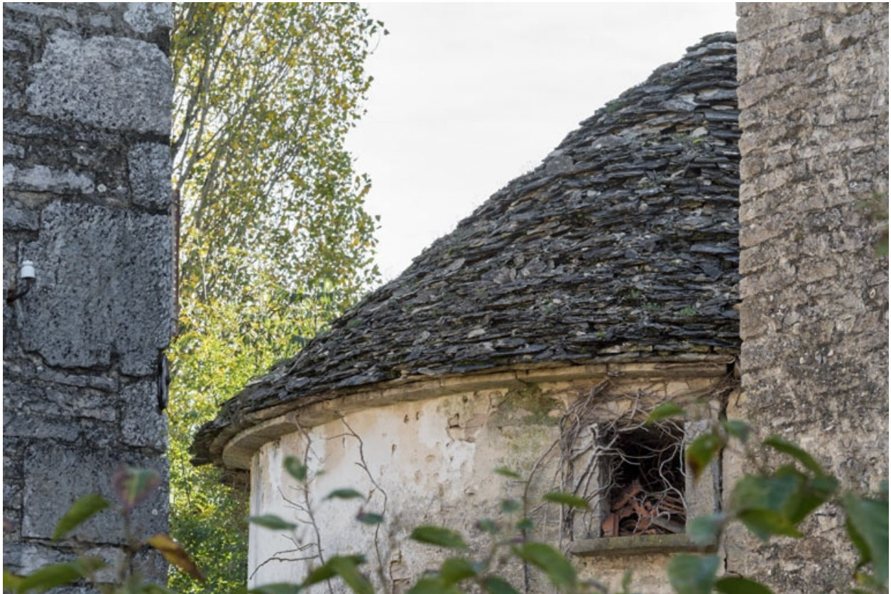
Détail de la toiture depuis le nord.
