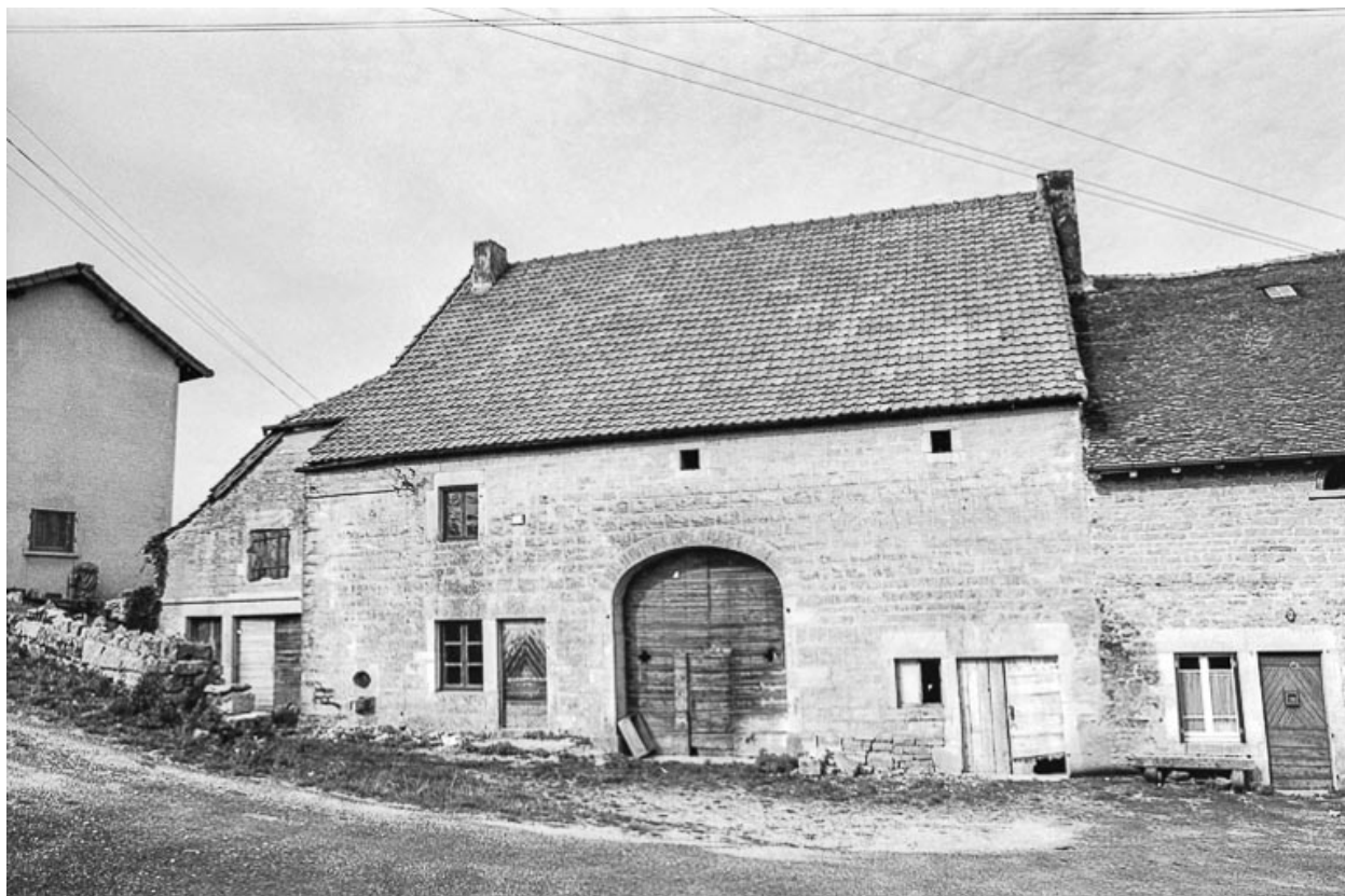
Ferme cadastrée D2 295 : façade antérieure.
