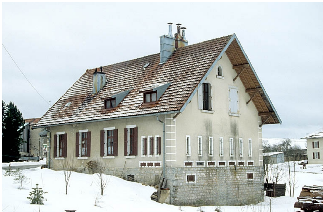
Façades postérieure et latérale droite.
