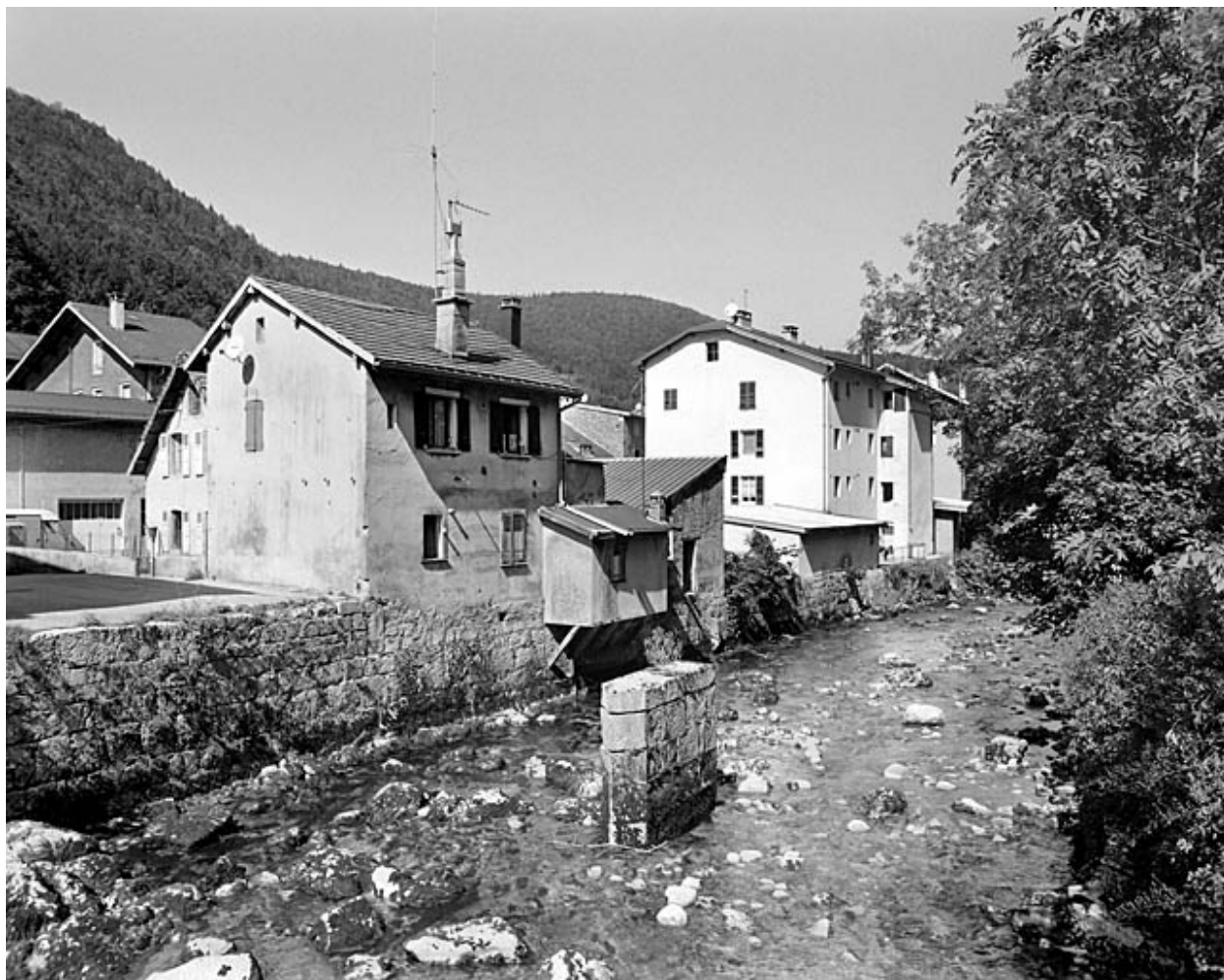
Vue d'ensemble, depuis le sud-est : élévations postérieures.
