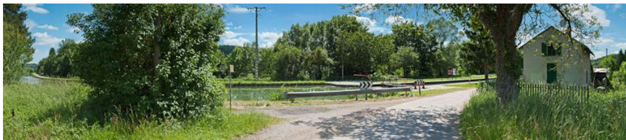
Vue du pignon droit de la maison.
