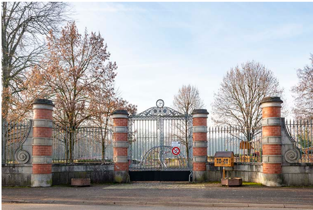
Clôture (grille) sur l'avenue des Pâtis.
