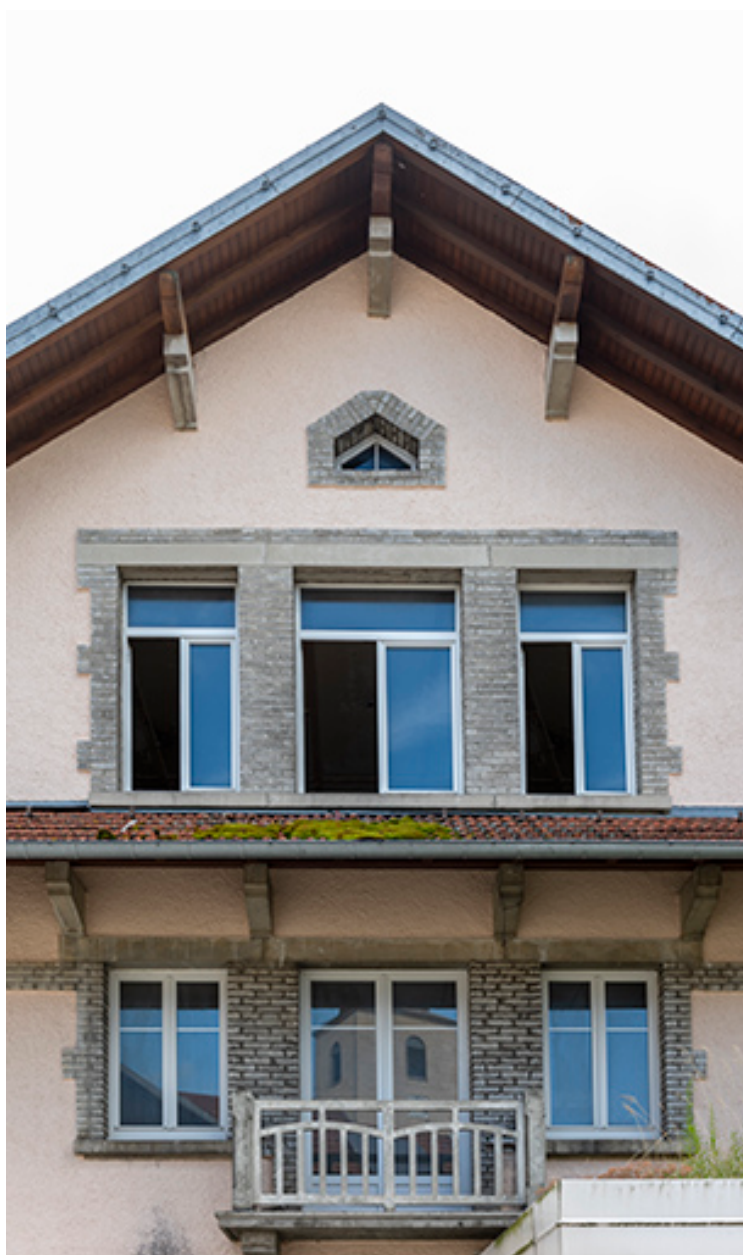
Façade antérieure : travées centrales en partie haute.
