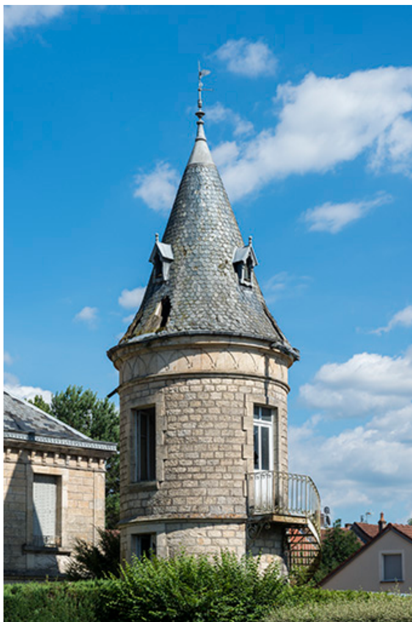
Tour, vue depuis le nord.
