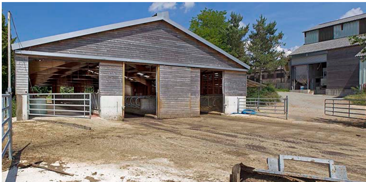
Pignon sud de l'étable ouest.
