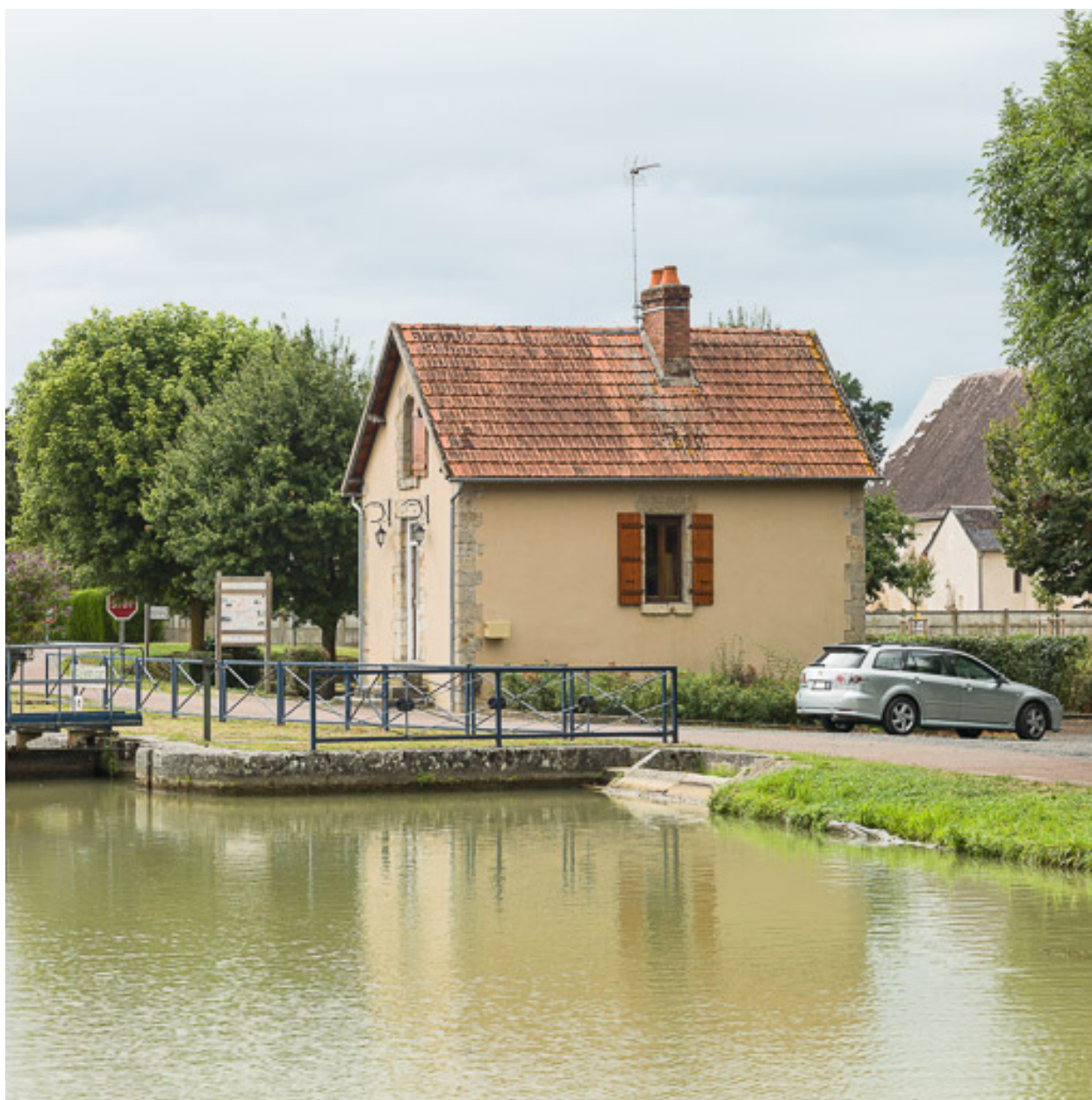
Vue de la maison éclusière.
