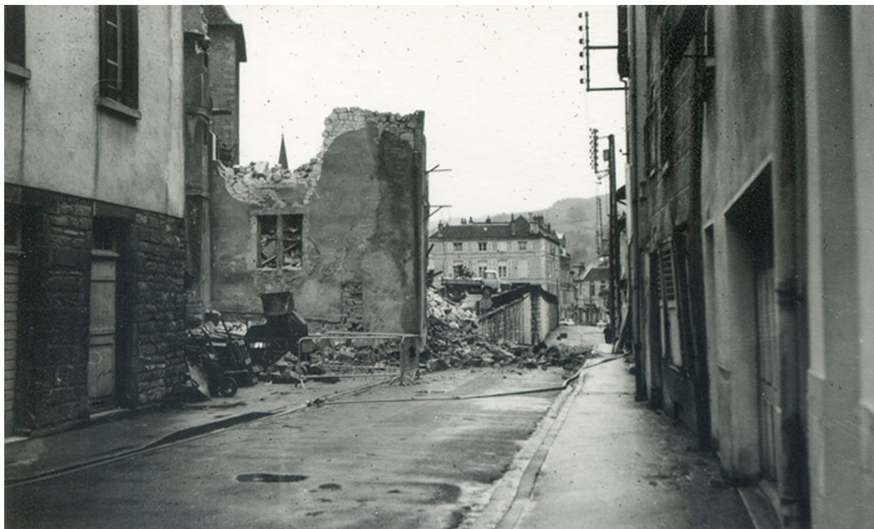
Démolition des bâtiments, vers 1973.
