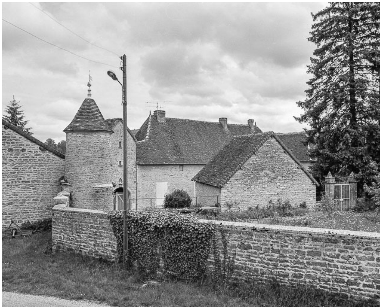
Demeure située chemin du Prélôt : vue d'ensemble.
