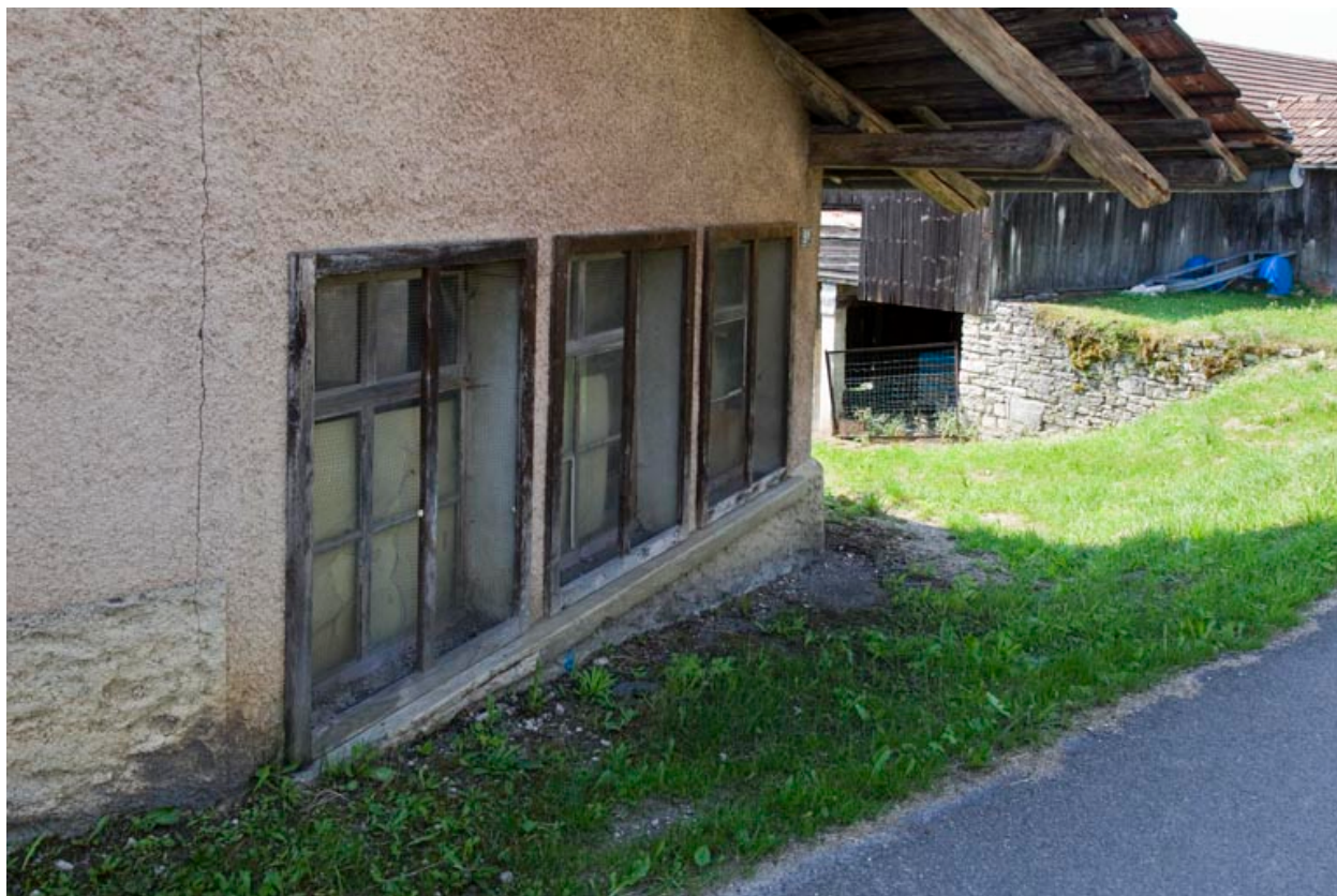
Fenêtres de l'atelier.
