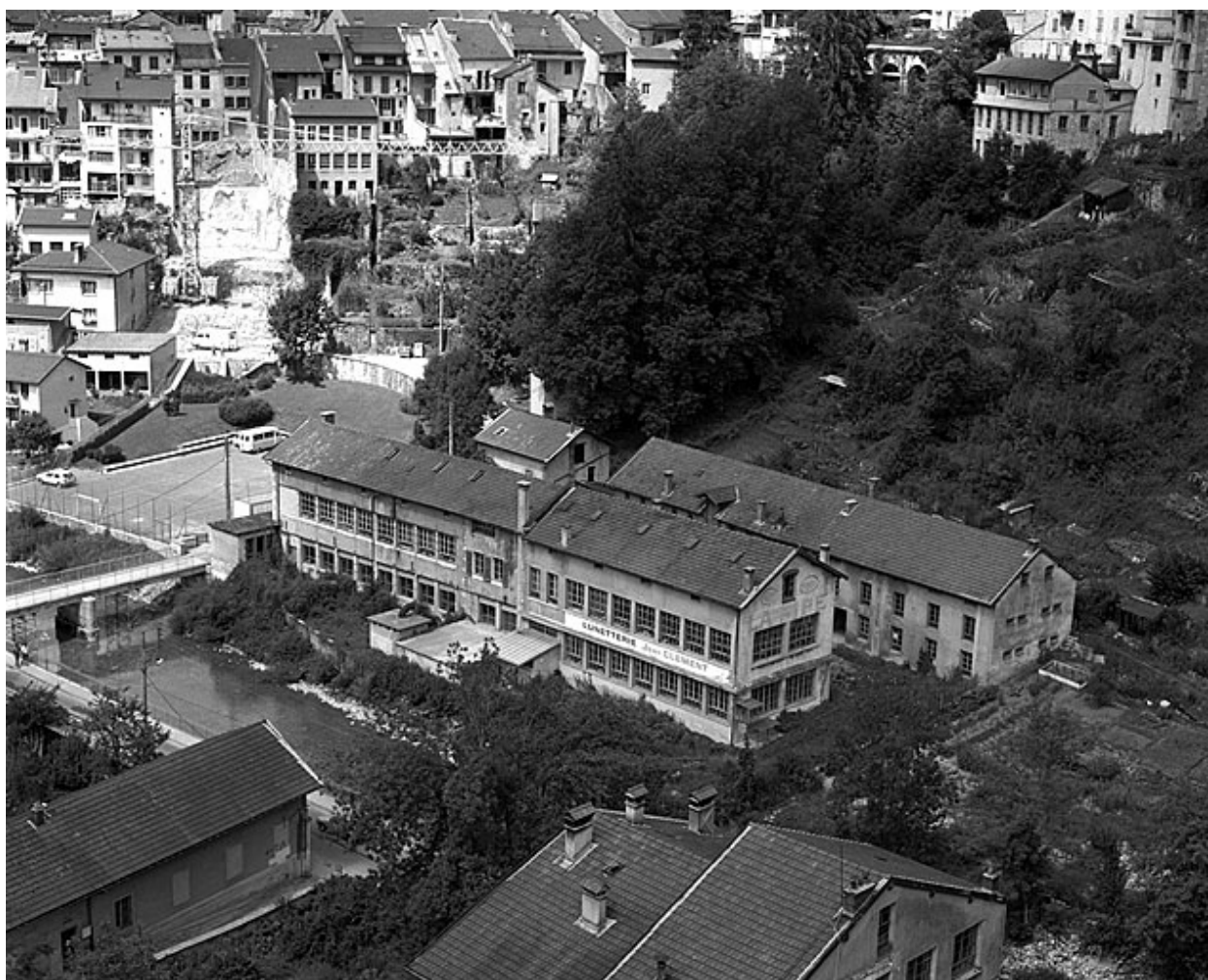
Vue d'ensemble plongeante depuis le sud-est.
