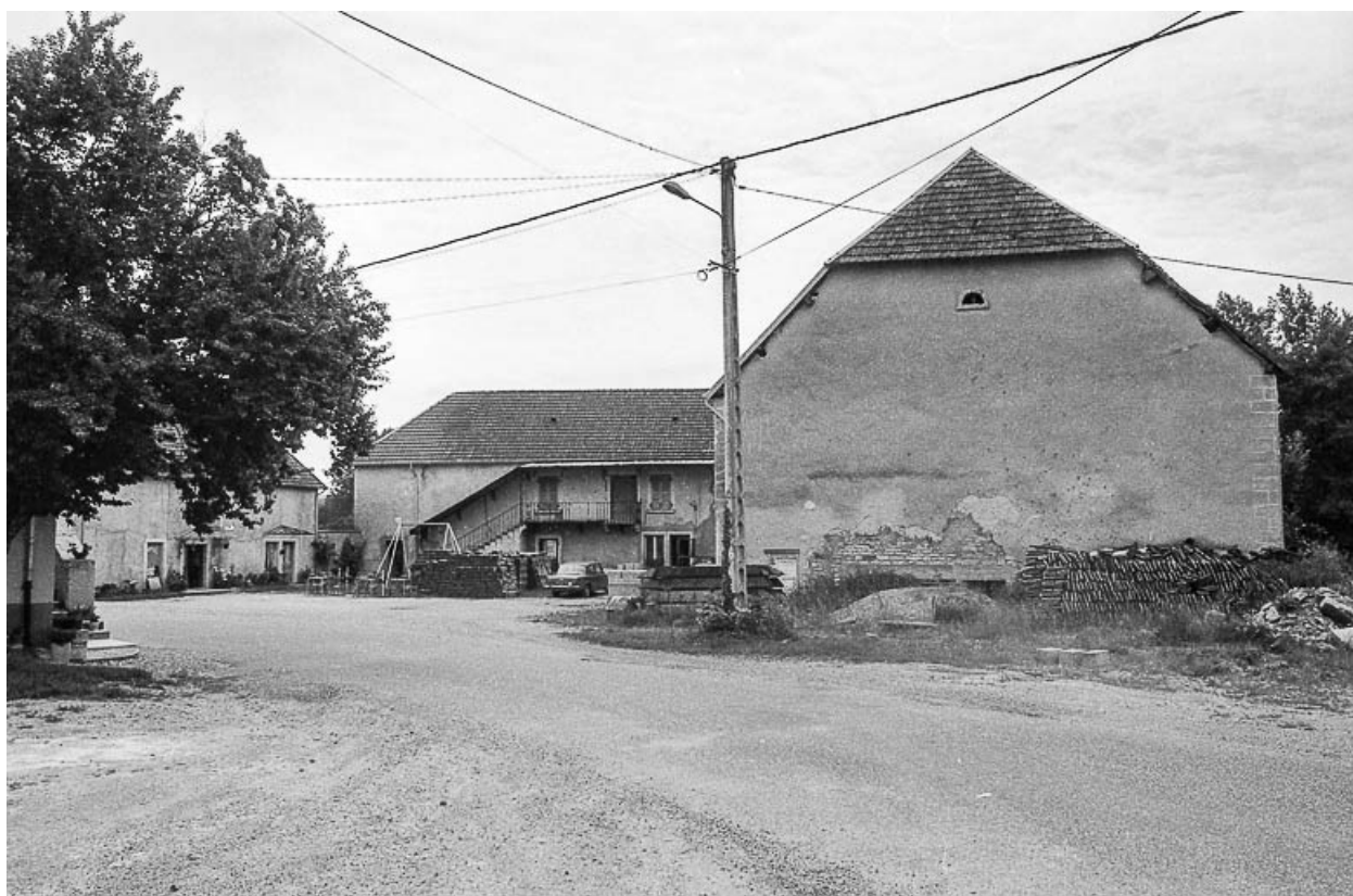
Vue d'ensemble des bâtiments en U.
