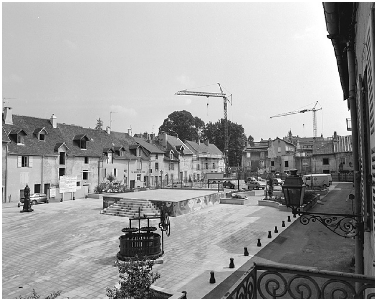
Rue de la Comédie et rue de Balerne.
