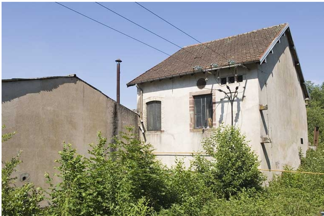
Bâtiment d'eau, actuellement transformateur.
