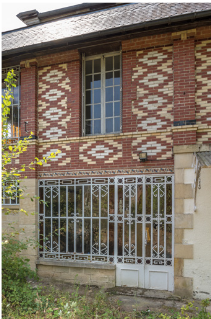
Élévation de l'extension en brique, côté nord.
