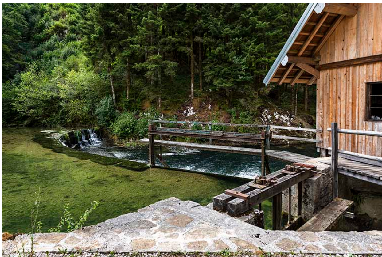
Barrage et vannes.
