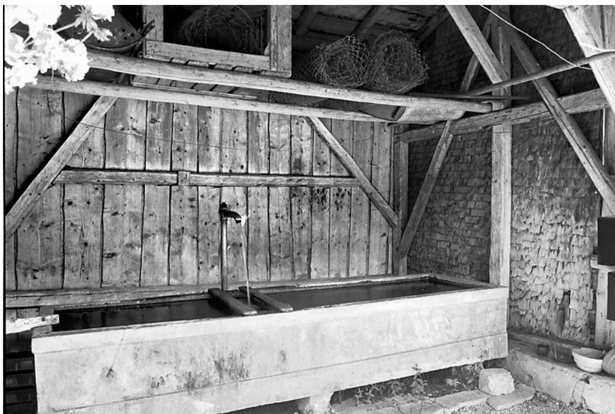
Vue du réservoir et de la charpente.
