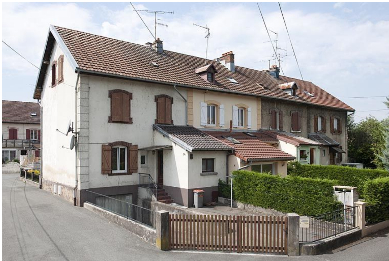
Habitation à 8 logements vue de trois quarts.
