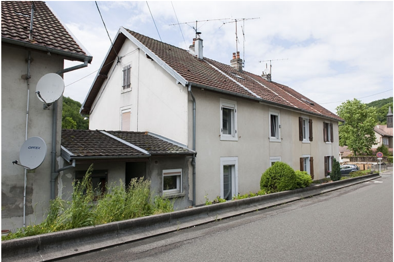
Habitation ouvrière vue de trois quarts.
