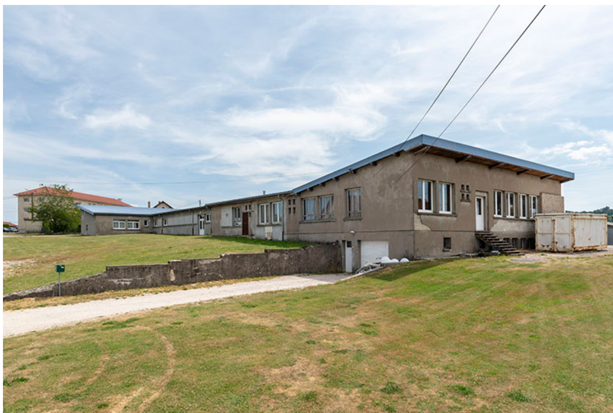
Façades postérieure et latérale gauche.
