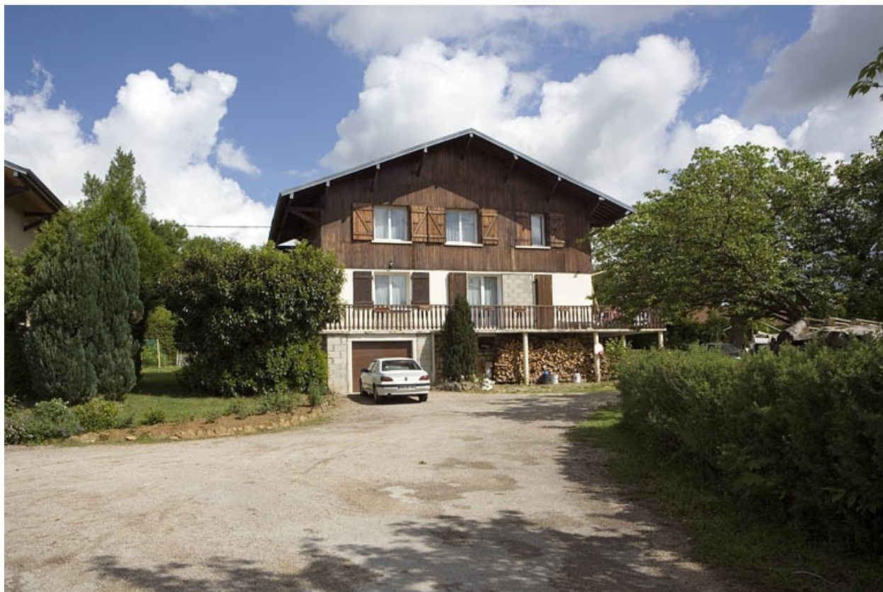
Maison de direction. Façade antérieure.
