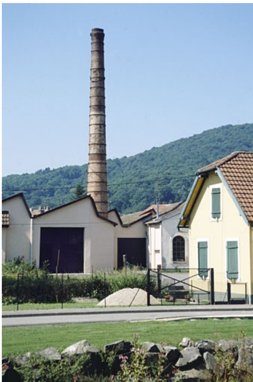
Ateliers de fabrication et cheminée depuis l'est.
