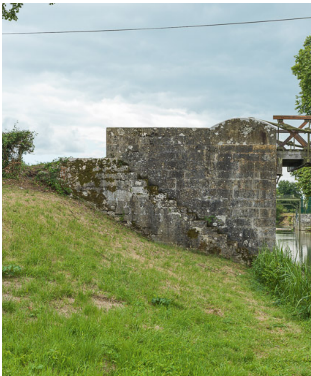
Détail d'une culée en moellons.
