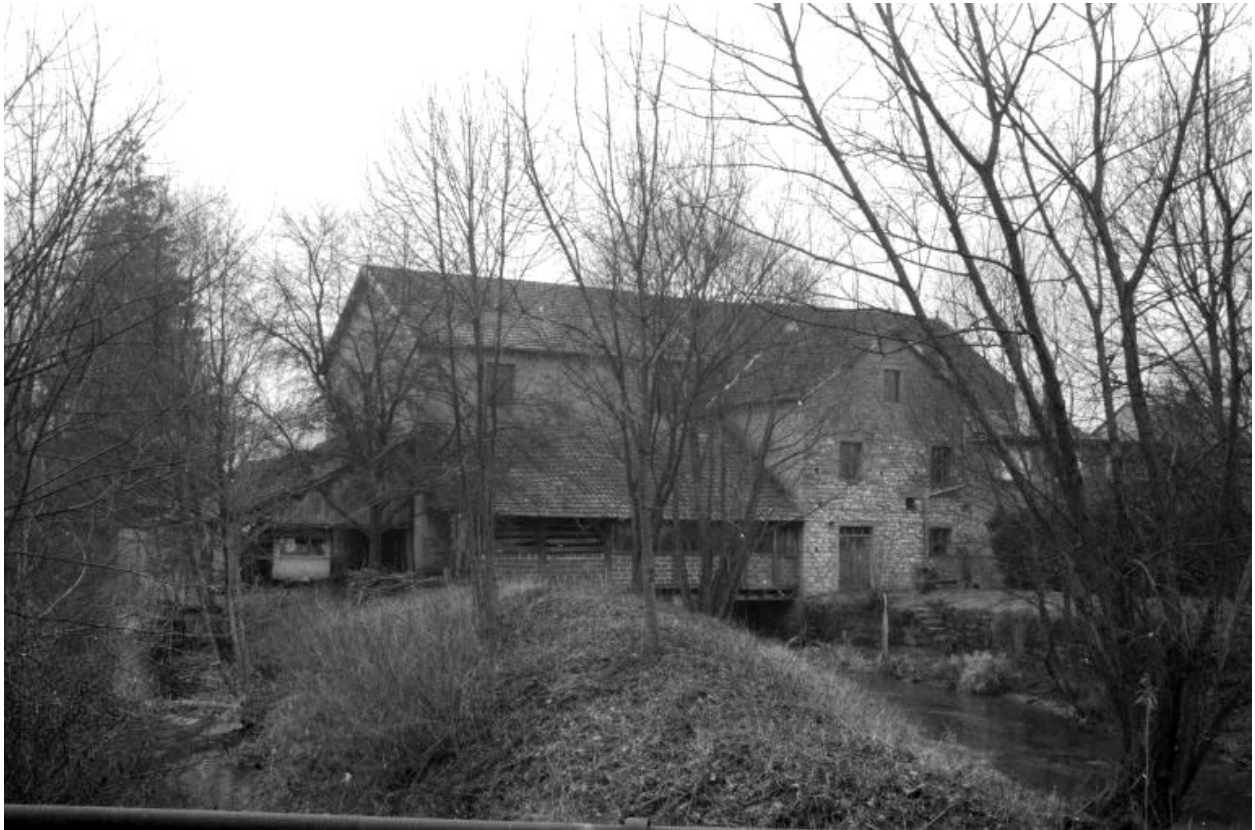
Façade postérieure de la minoterie.
