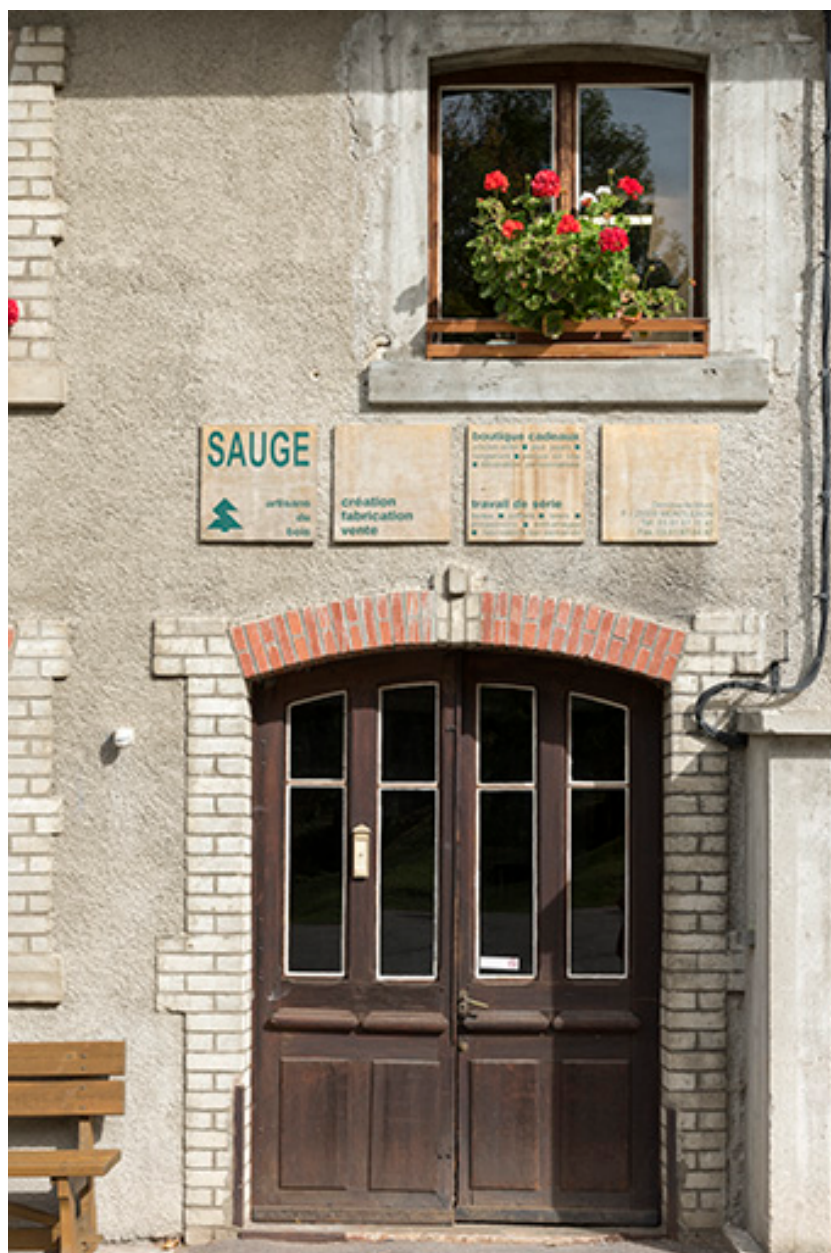
Atelier de fabrication : entrée.
